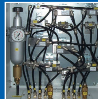
Steuerschrank für pneumatische Weichen
